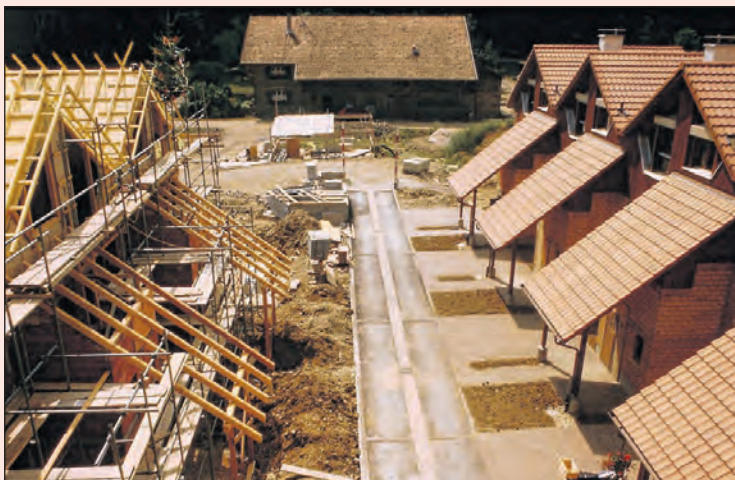
Beim Bau der Häuser Stettbrunnweg 53–61. Foto H.U. Recher, Stettbrunnen
