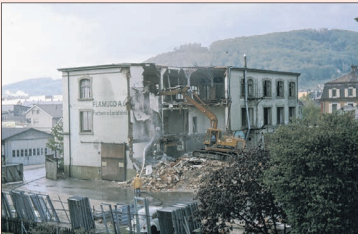
Abbruch Fabrikgebäude Flamuco, Mai 1982.
