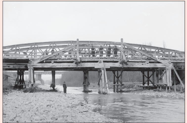
Vorgestern: Im Vordergrund ist die alte Holzbrücke und unmittelbar dahinter die neue Eisenbrücke sichtbar. Im Hintergrund sieht man die alte Eisenbahnbrücke von 1854.
