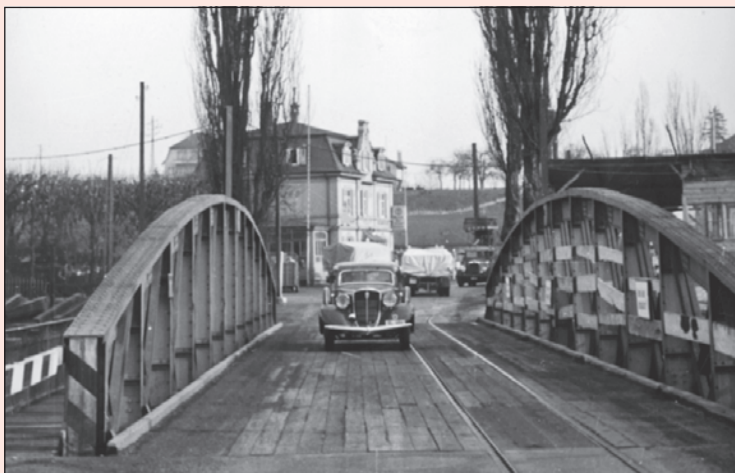
Gestern: Die Brücke wurde nach Eröffnung der Tramlinie auch als Trambrücke verwendet.
