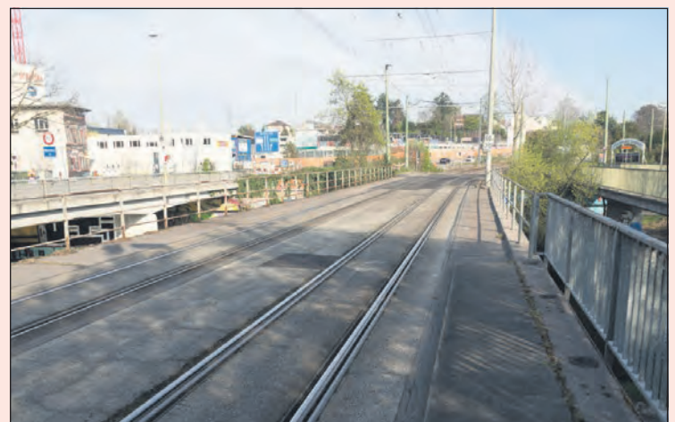
Heute: Tram-Brücke über die Birs, 2019.
