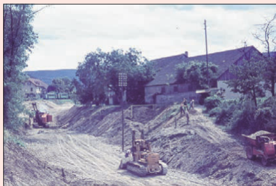
Damals: Bau der Tramlinie auf Höhe der damaligen Gärtnerei Dobler (rechts). Im Hintergrund fährt ein Tramzug auf der alten Strecke, 1951.
