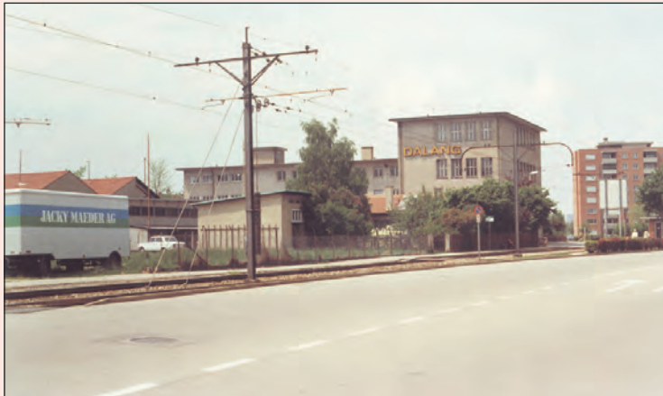
Gestern: Die Fabrikationsgebäude der ehemaligen Dalang Teigwarenfabrik vor dem Abriss in den 80er Jahren.
