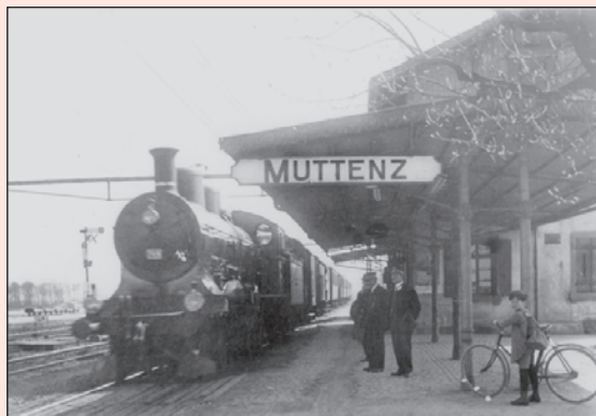
Die Bahnstation MuttENZ damals um 1896.
