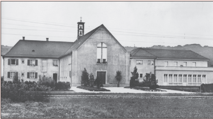
Die katholische Kirche von 1932 an der Tramstrasse, links Pfarrhaus mit kleinem Saal, rechts Jugendheim mit Wohnung der Ordensschwester, Kindergarten und Krankenpflege. Museen Muttenz Lizenzbedingungen CC BY-SA 4.0
