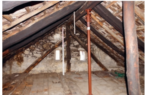
3.4 Blick von innen an die nördliche Giebelwand mit den Sparren, der Firstpfette und den Langbändern, die mit dem Ständerbau verbunden sind
